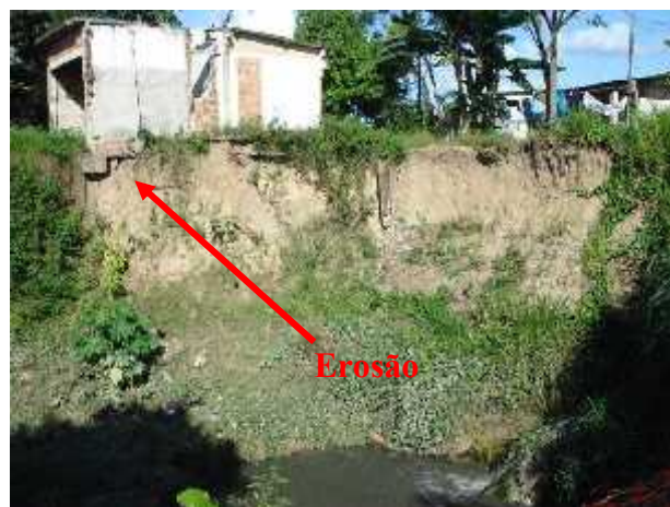
Figura 7: REC2 – Intenso processo erosivo na margem do curso d'água, contribuindo para o desabamento de parte da moradia. (12/2010).
