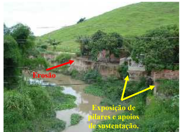
Figura 4 e 5: RERD – Observação de erosão das margens, lançamento de esgoto e comprometimento das bases estruturais das moradias. (12/2010)
