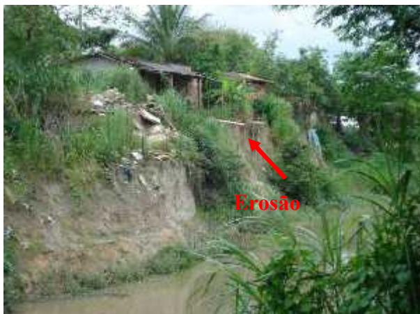
Figura 4 e 5: RERD – Observação de erosão das margens, lançamento de esgoto e comprometimento das bases estruturais das moradias. (12/2010)
