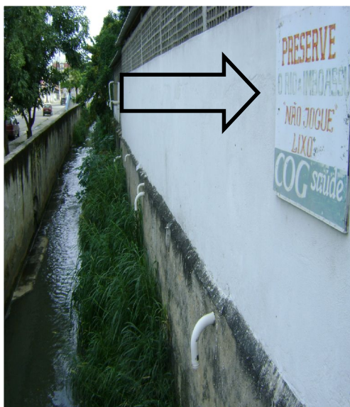
Figura 5 – Placa informativa: “Preserve o rio Imboaçú – Não jogue lixo”, e logo abaixo, vários canos de esgoto. Foto: Felipe Saraiva
