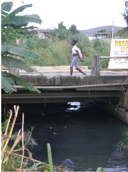
Figura 15 - Ponte situada em baixa altura. Foto: Felipe Saraiva
