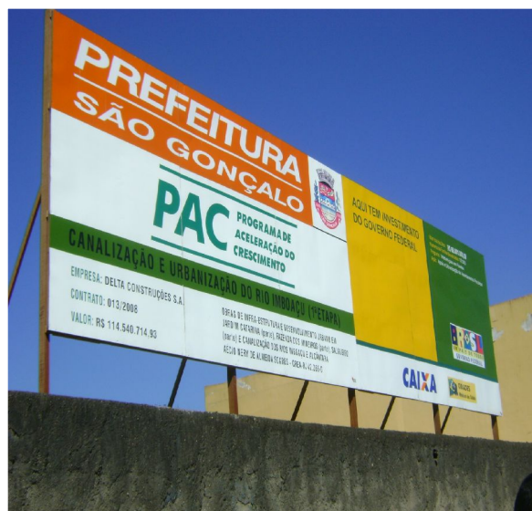
Figura 17 – Obras do PAC realizam intervenção no rio Imboáçu. Canalização e Urbanização Foto: Felipe Saraiva
