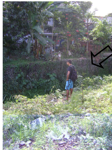
Figura 7: Blocos de pedras auxiliando na contenção das margens e na percolação e infiltração da água. Foto: Felipe Saraiva
