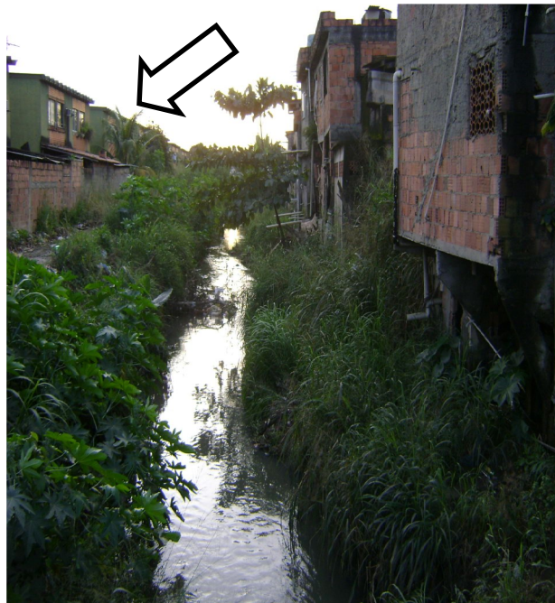
Figura 21 – Construções irregulares próximas às margens do rio. Foto: Felipe Saraiva
